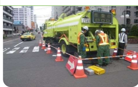
高圧洗浄車にて管内を洗浄します。
